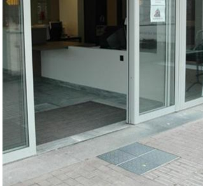
Enter vzw – de ingewerkte vloermat sluit drempelloos aan met de toegangsdeur en de bevoering in het gebouw
