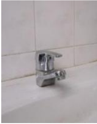
Akabe De Kim Zottegem: Een eenhendelkraan is makkelijk bedienbaar zelfs met een vuist of elleboog.
