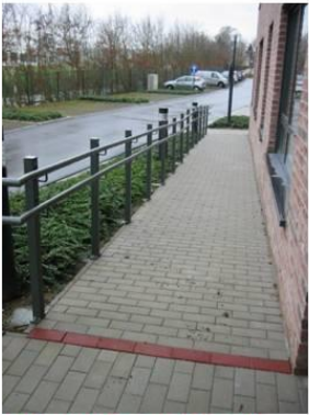
Hellingen zijn voldoende breed. Het percentage is afgestemd op de lengte en het te overbruggen niveauverschil. Het begin en einde wordt gesignaleerd.
