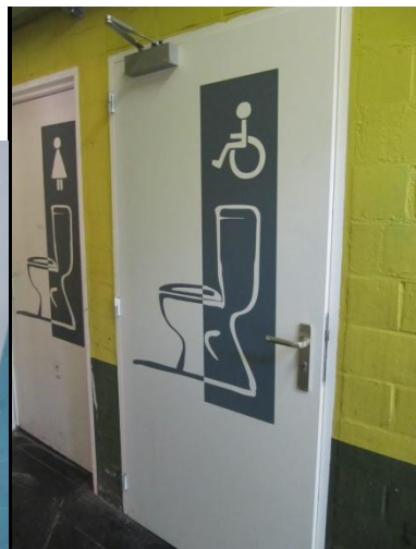
Foto links: FOS de toekan: De klink is niet duidelijk zichtbaar omdat ze dezelfde kleur heeft als de deur. Foto rechts: Scouts Akabe Lint. Een duidelijk zichtbare deur doordat de witte deur contrasteert met de wand, het logo en de klink contrasteren dan weer met de witte deur.
