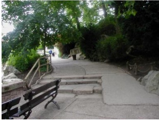
Een combinatie van een helling en een trap in beton. Let wel op, er is geen afrijdbeveiliging en geen leuning aan de helling.
