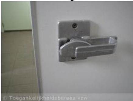
Een slotje met een verlengde hendel is makkelijk in gebruik. Je moet er weinig kracht op zetten en je hebt er geen fijne motoriek voor nodig.
