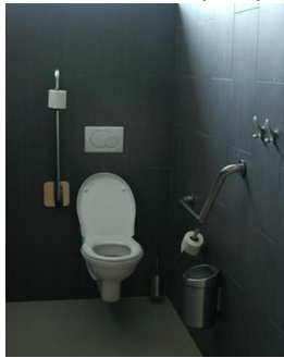
Een vaste beugel aan de wand en een opklapbare aan de open zijde.
