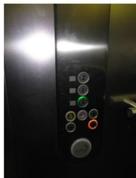
Het bedieningspaneel is op de zijwand geplaatst, min. 50 cm uit de hoek. De knoppen zijn visueel en tactiel aangeduid. Knoppen en displays contrasteren best met de rest van de lift. – jeugdhuis Ahoy Wijnegem
