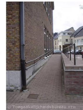
Aan beide zijden is een (dubbele) leuning aangebracht op twee hoogtes. Boven- en onderaan de helling loopt de leuning 40 cm door.
