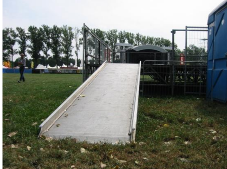
Een hellingsbaan naar een podium. De helling is wel te steil om zelfstandig bruikbaar te zijn.
