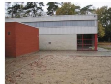
De belangrijkste (toegangs)paden zijn voorzien van een rolstoelveste ondergrond (effen, aaneengesloten en stroef) - Scouts Neerpelt (verhard pad naar en rond het gebouw)
