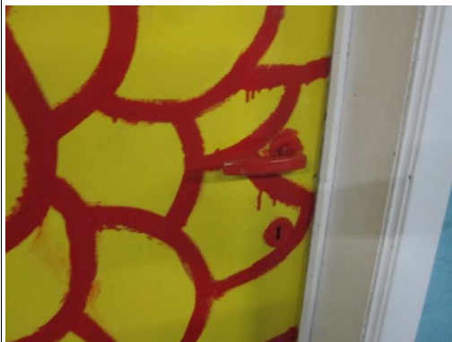
Foto links: FOS de toekan: De klink is niet duidelijk zichtbaar omdat ze dezelfde kleur heeft als de deur. Foto rechts: Scouts Akabe Lint. Een duidelijk zichtbare deur doordat de witte deur contrasteert met de wand, het logo en de klink contrasteren dan weer met de witte deur.
