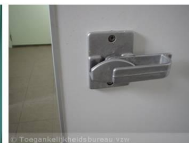
Sluitsystemen zijn makkelijk hanteerbaar vb. met een verlengde hendel of hefboom
