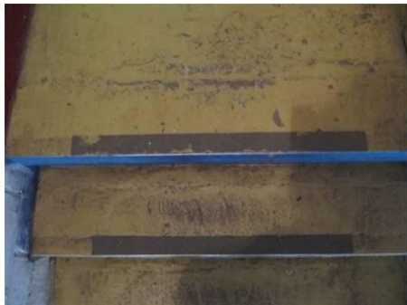
Voor een veilig gebruik moeten treden en bordessen voorzien zijn van een contrastmarkering. – 47 ste Akabe Koningin Fabiola Edegem
