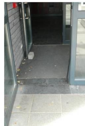
Deuren zijn voldoende breed voor een goede passage – Jeugdcentrum Rondpunt Genk
