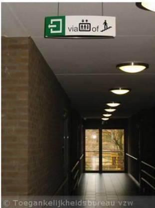
Routes zijn voldoende hoog, ook obstakels in de hoogte zoals lichtarmaturen, signalisatie... worden goed uitgevoerd.
