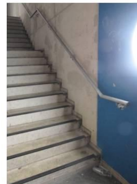
Boven- en onderaan de trap loopt de leuning 40 cm door – Jeugdcentrum Ahoy Wijnegem
