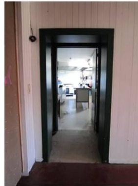
Drempels op de looproute worden vermeden, kleine niveauverschillen worden opgevangen door een helling - Akabe De Kim Zottegem
