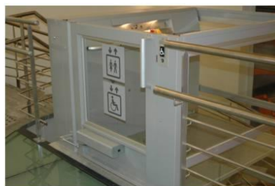
Een verticale plateaulift (in een koker) kan gebruikt worden als de hoogteoverbrugging beperkt is (één verdieping).
