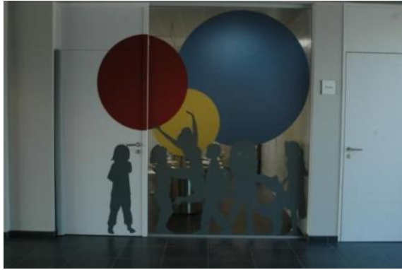
Foto: Een goede vorm van een contrastmarkering door op het glas een afbeelding aan te brengen. Zo is er een goed evenwicht tussen het doorzicht van het glas en de zichtbaarheid van het glas om te vermijden dat je er tegen loopt.
