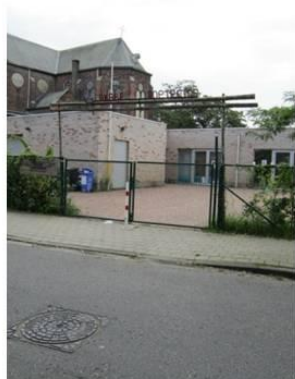
Drempels worden vermeden bij overgangen tussen verschillende materialen of zones - Akabe Toetertoe Terhagen
