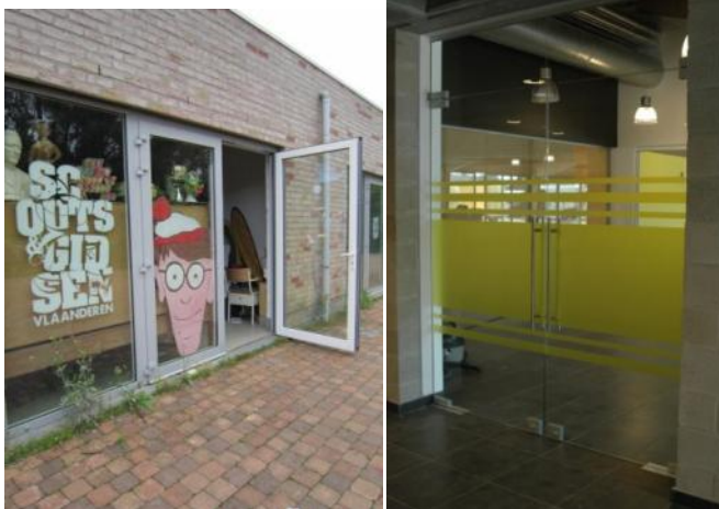
Foto links: Akabe Toetertoe Terhagen heeft zijn glazen inkomdeur voorzien van goede contrastmarkering. In de markering werd het logo van Scouts en Gidsen Vlaanderen verwerkt. Foto rechts: Een goede vorm van contrastmarkering door rechte stroken in een contrasterende kleur op het glas aan te brengen.
