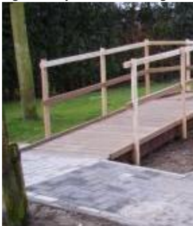
De houten trap heeft tegen de zijkanten een houten lat als afrijdbeveiliging.
