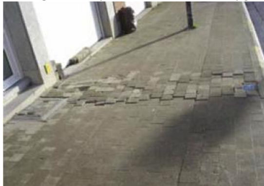
Na verloop van tijd is de verharding omhooggekomen. Dit vormt nu een obstakel.
